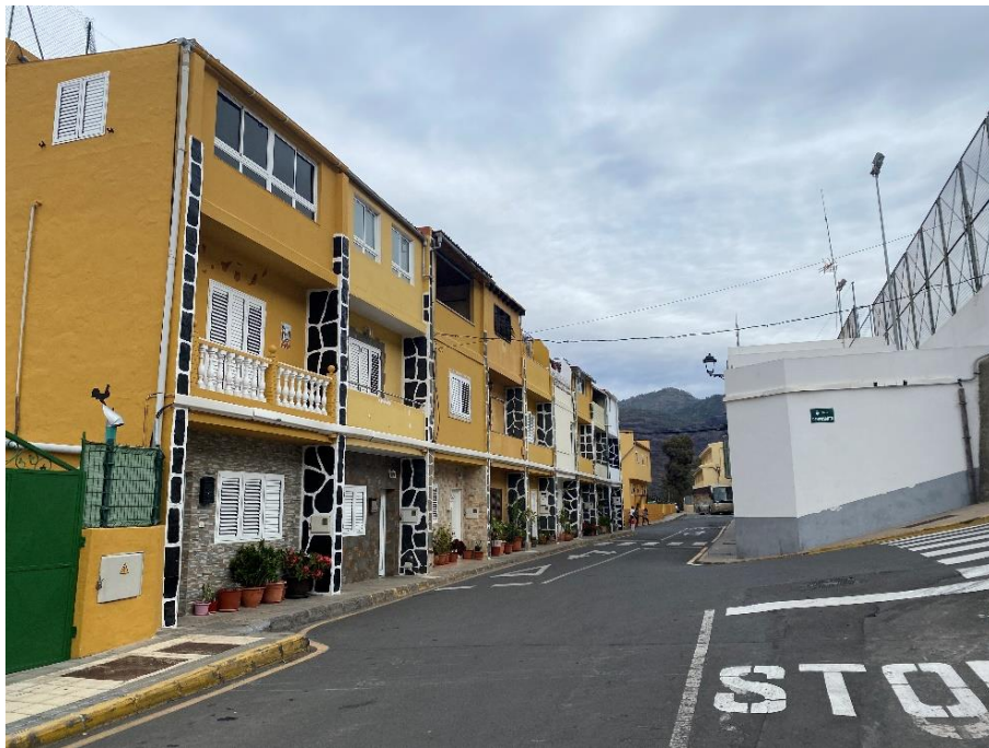
Aceras estrechas. Ausencia de bordillo adaptado y pavimento podotáctil en paso de peatón. Fuente: LPA Studio.
