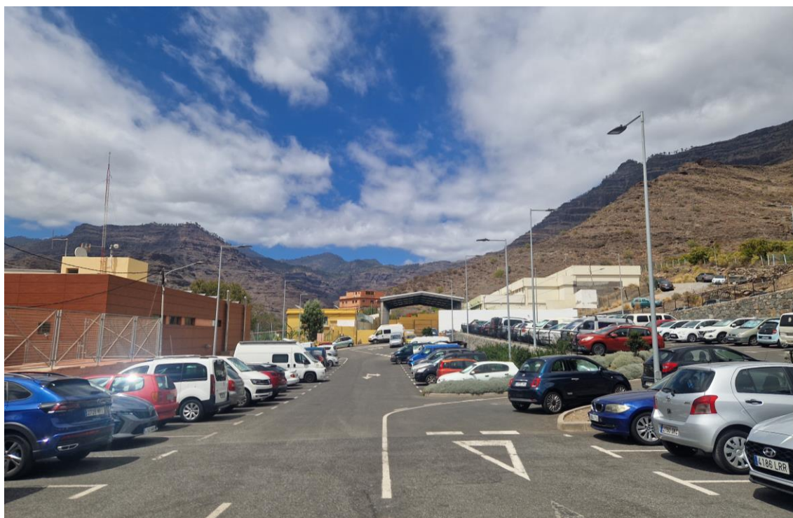
Vista del aparcamiento ejecutado. Fuente: LPA Studio.
