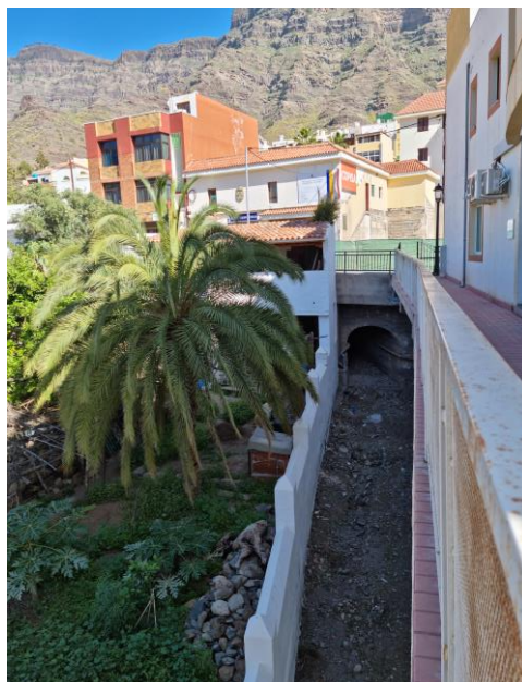
Canalización de la escorrentía El Drago a su paso por la Avenida de La Constitución. Fuente: LPA Studio.
