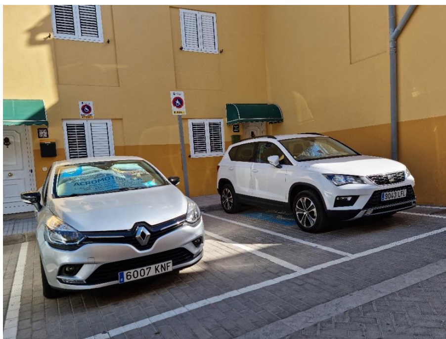
Plaza PMR con las dimensiones obligatorias. Fuente: LPA Studio.
