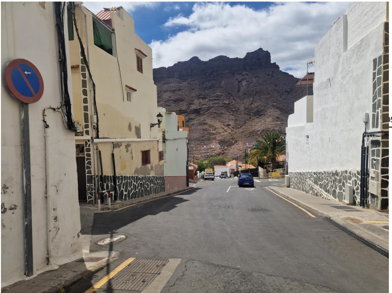
Imagen de la C/ San Antonio de Padua ensanchada mediante el proyecto de demolición (expte. 21-OBR-03). Fuente: LPA Studio.
