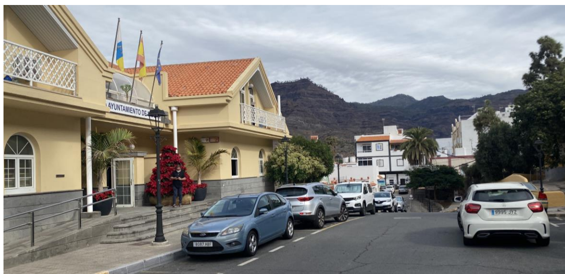
Vista del alzado del Ayuntamiento de Mogán. Fuente: LPA Studio.
