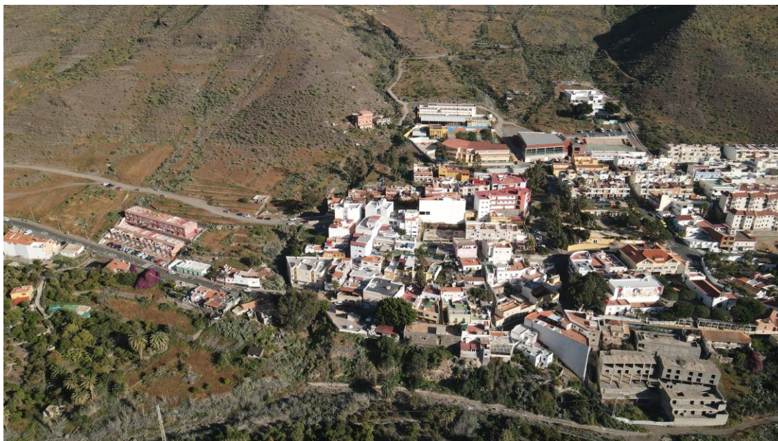
Vista aérea de las edificaciones del borde del barranco en la parte norte del ámbito de ordenación, con grandes medianeras vistas o incluso sin terminar de ejecutar, junto a zonas escarpadas. Fuente: Manuel Álvarez (piloto dron).
