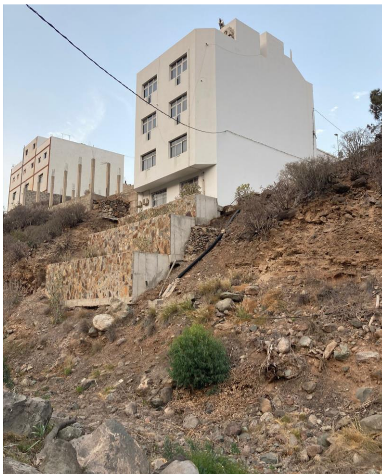
Edificación municipal con muros de contención en forma de bancales, con acabado pétreo de colores similares a los del entorno. Fuente: Ayuntamiento de Mogán.
