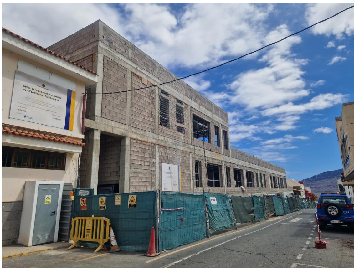
Vista de la obra en ejecución. Fuente: LPA Studio.
